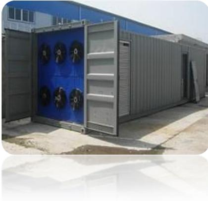
La chambre frigorifique de stockage de glace peut être construite et utilisée dans un container certifié ISO. Ce système vous offre une grande liberté de déplacement et un moyen de ravitaillement aisé.
